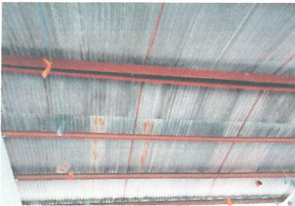
Foto 3: Area donde se desea el mejoramiento del techo en el nivel primario
