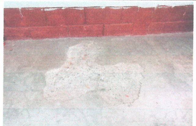
Foto 4: Area donde se desea el mejoramiento de piso en el nivel primaria
